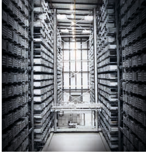
UNICOMPACT chez un fabricant de profilés en aluminium.
