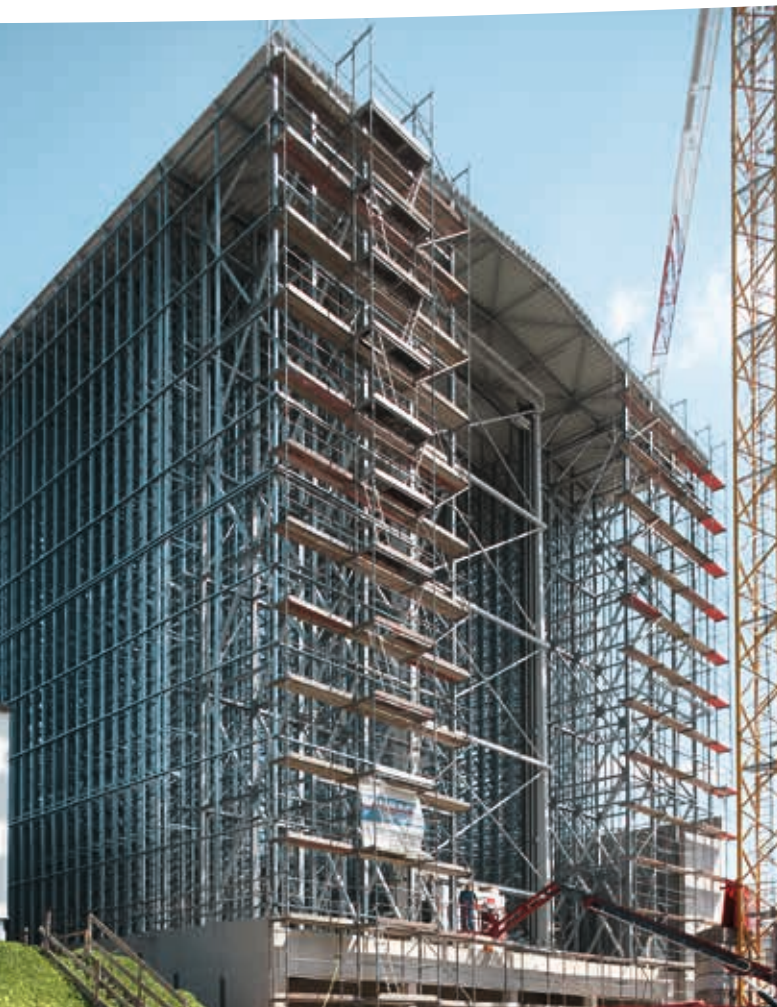
UNICOMPACT en montage, en version porteuse de hall.
