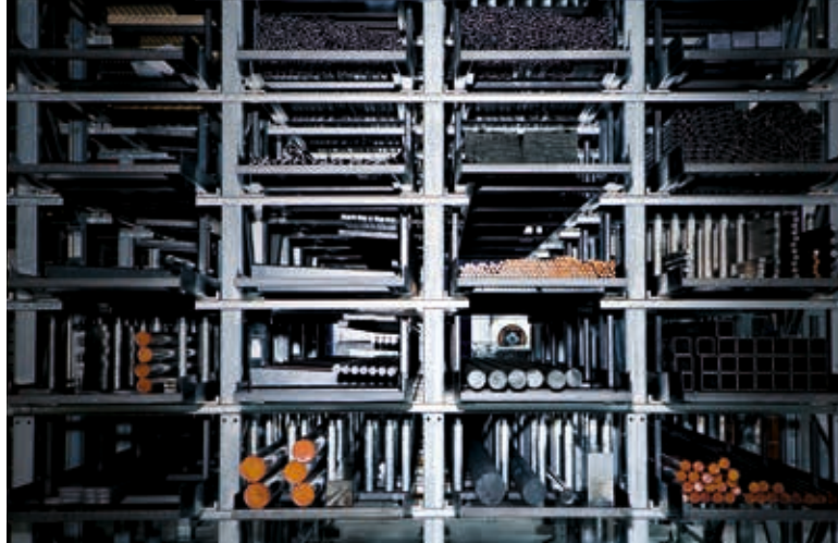
Vue sur la construction métallique du magasin en nid d'abeilles avec cassettes en fonctionnement mixte (cassettes automatiques et standards)
